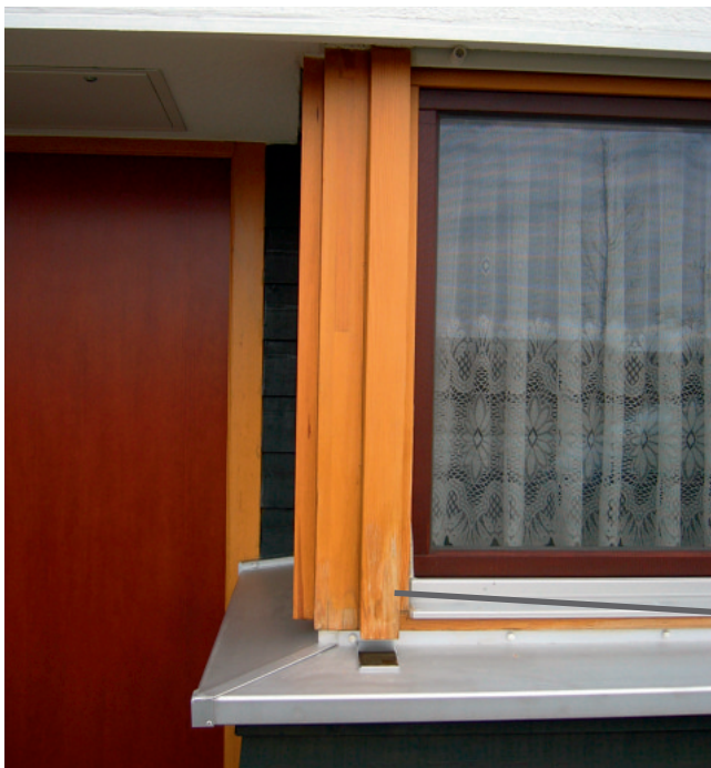
Die notwendigen Instandhaltungsintervalle sind nicht eingehalten worden. Das Holz hat erste Schäden.
