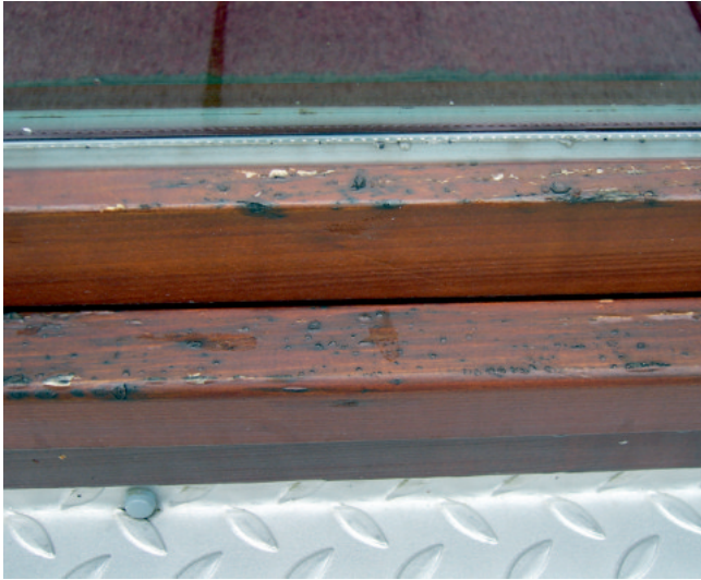
Eine durch Hagelschlag beschädigte Oberfläche muss schnell erneuert werden. Sonst kommt es zu Verfärbungen und Unterwanderung des Anstrichs durch Feuchtigkeit.
