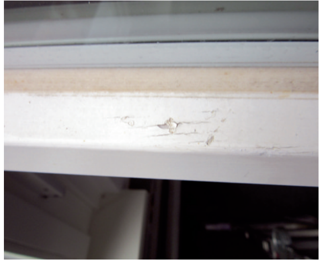
Hagelschaden bei deckenden Fensteranstrichen.
